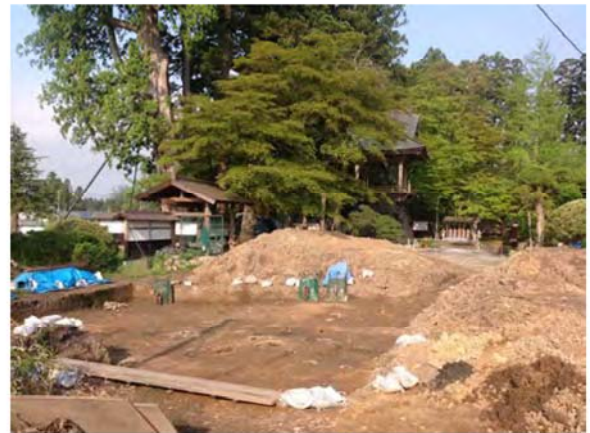
↑発掘調査(屋外トイレ予定地)
