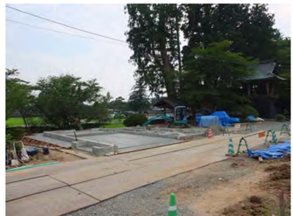
↑屋外トイレ基礎工事(8/8現在)
