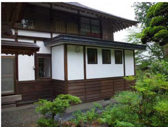
↑信徒用トイレ 外観
